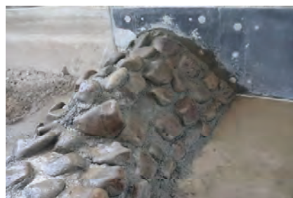
魚道左岸の石組状況
