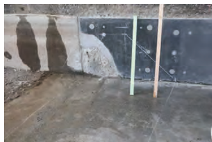
下流端隔壁取り壊しと石組形状
