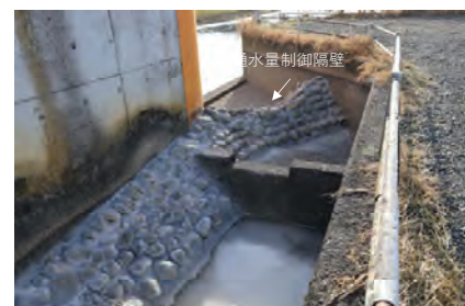
魚道上流部石組状況（通水量制御）
