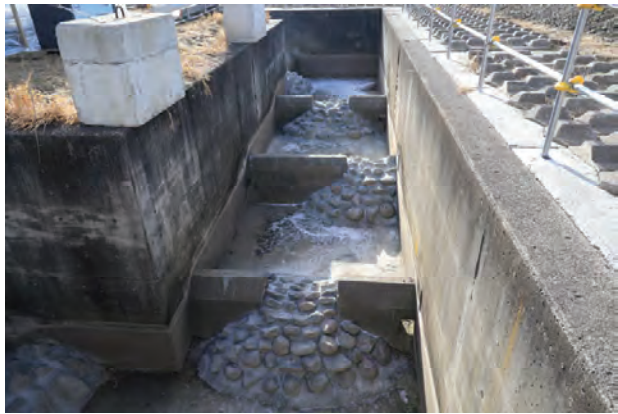
魚道隔壁部石組（ハゼ類の遡上にも有効）（切欠き部）
