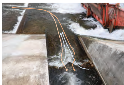
魚道下流端隔壁の改良
