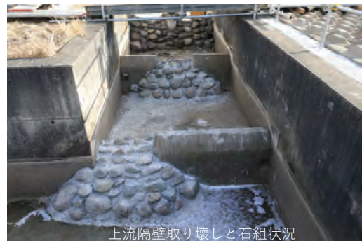
上流隔壁取り壊しと石組状況
