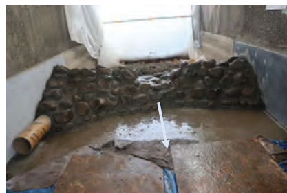
魚道隔壁の石組状況 (下流から上流)
