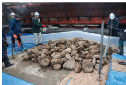
石組隔壁の使用石材 \phi 200~300
