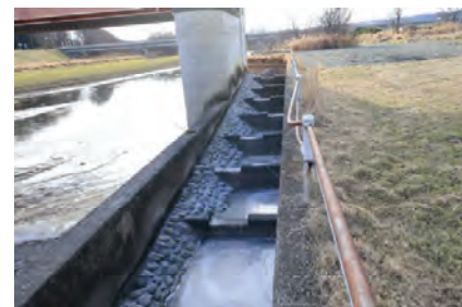
魚道側壁部状況（下流から上流）
