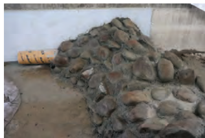
魚道右岸の石組状況
