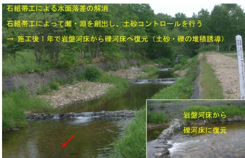
図-6 北海道内の河川における石組み水制帯工の整備事例 (設計：(株)エコテック、現地指導：(一社)流域生態研究所)
