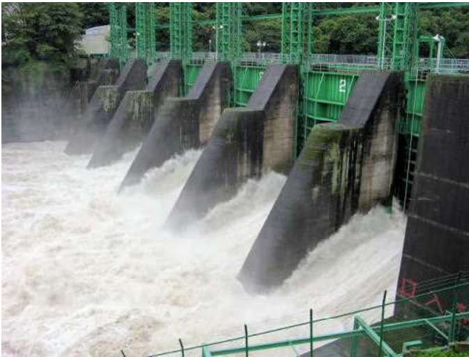
写真4 危険水位に近づくと一斉放水される
