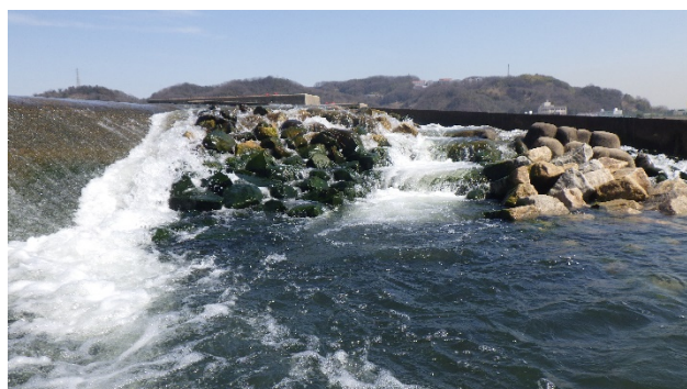
石組み魚道(岡山県高梁川潮止め堰)
