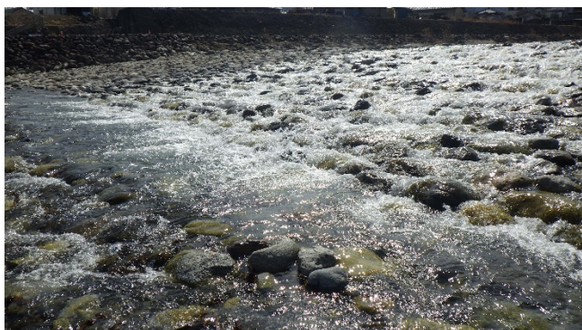
粗礫斜路式魚道(大武川床固工)
