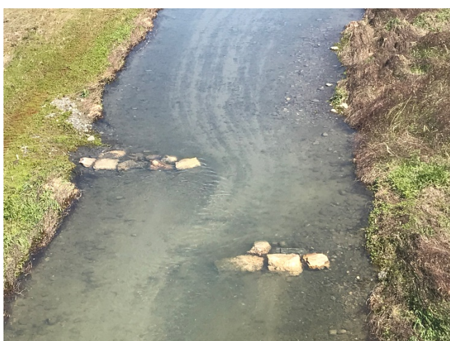
石組み水制工(静岡県一雲濟川)
