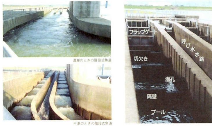
図-2 筑後大堰の魚道
