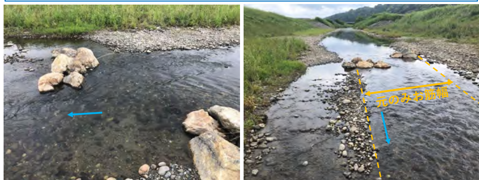
石組み設置から約3カ月後の状況（令和4年5月）
