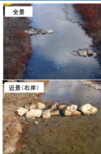
石組み設置直後（令和2年12月） 18
