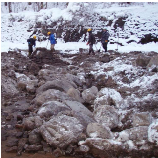
写真-7 石積み状況
